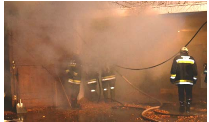
Brand einer Hackschnitzelheizung in Staning
