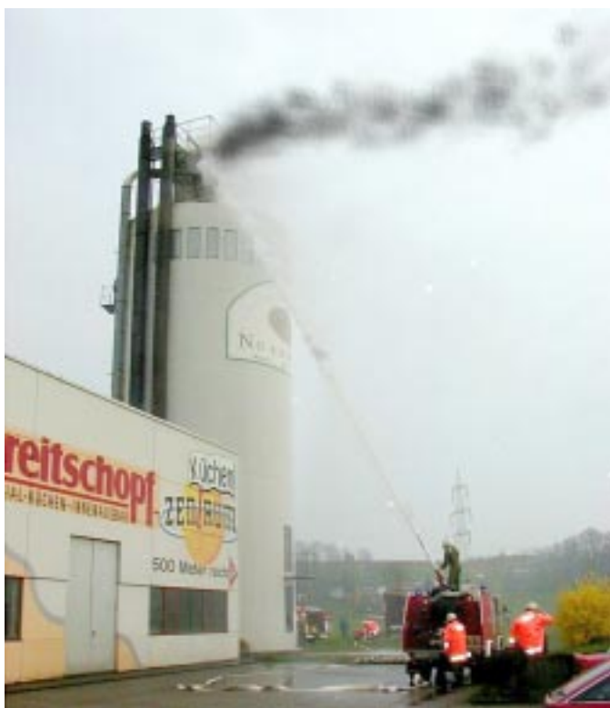
Brand am Hackschnitzelsilo der Firma Breitschopf
